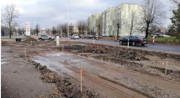
A1 autoceļa remontdarbi arī ziemā turpinās
