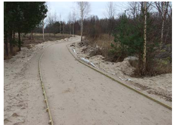
Takā uz pludmali Ainažos būs Versaļas segums, tas nodrošinās operatīvā transporta piekļuvi pludmalei
