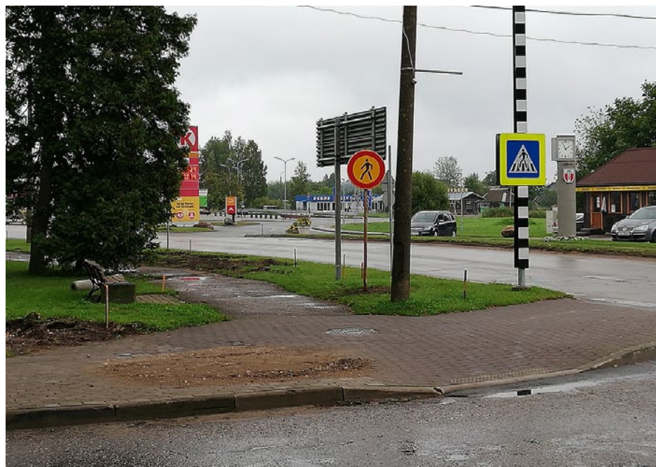
Remontdarbu laikā ir slēgta Viļņu ielas ietve
