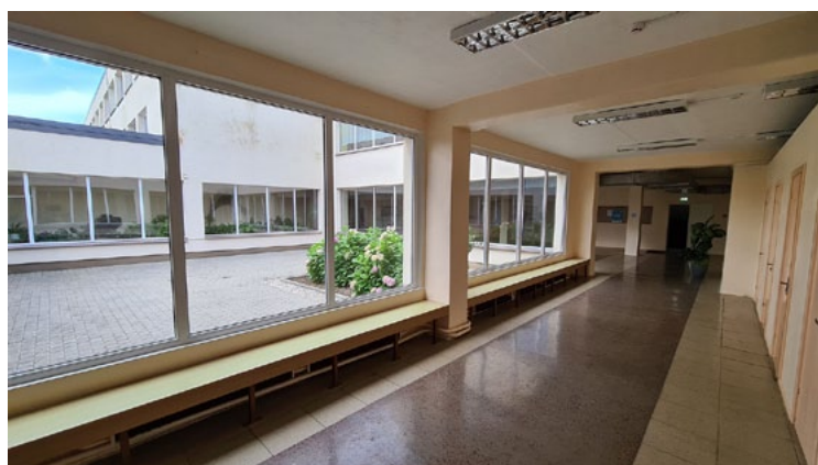
Liepupes pamatskolā veikts remonts 1. stāva gaitenī
