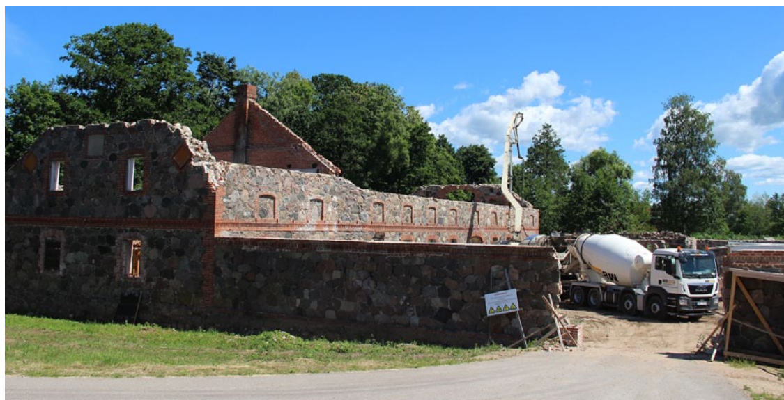
Svētciema muižas stallī notiek betonēšanas darbi
