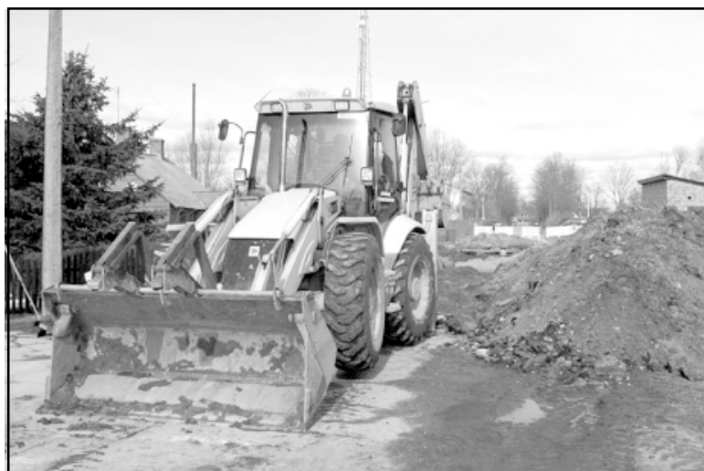
Sila ielā rit dzeramā ūdens atdzelžošanas stacijas un ūdensvada izbūve
