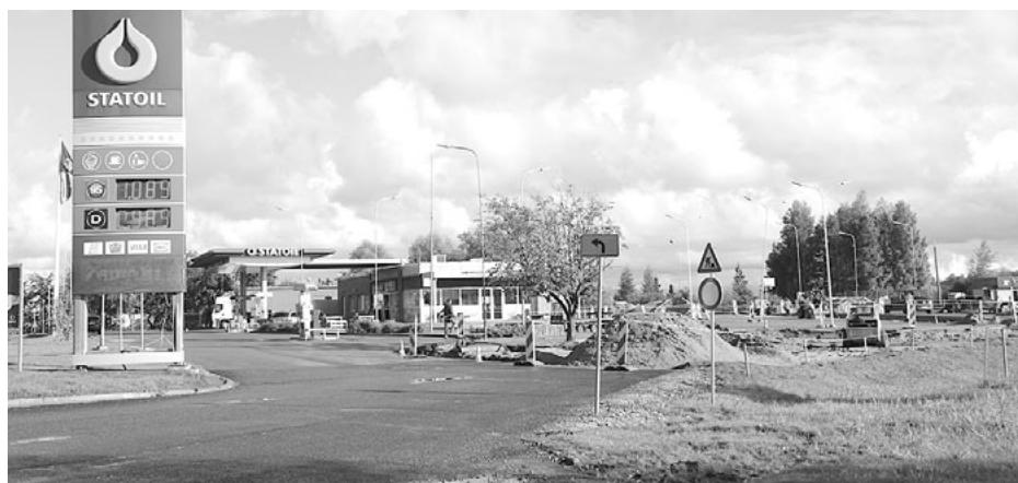
Notiek remontdarbi Statoil Salacgrīvā
