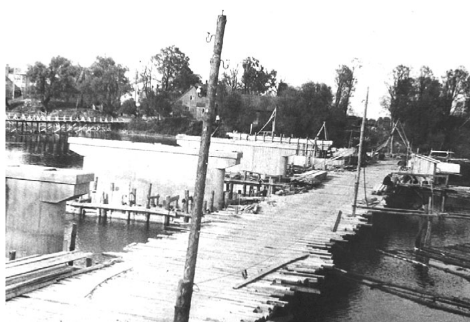
Šajā fotogrāfijā redzami 3 tilti - pagaidu, jaunā balsti un vecais koka tilts
