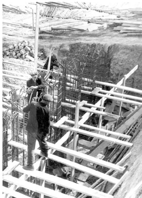
Balstu betonēšana
