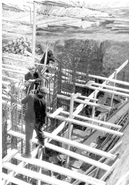
Balstu betonēšana
