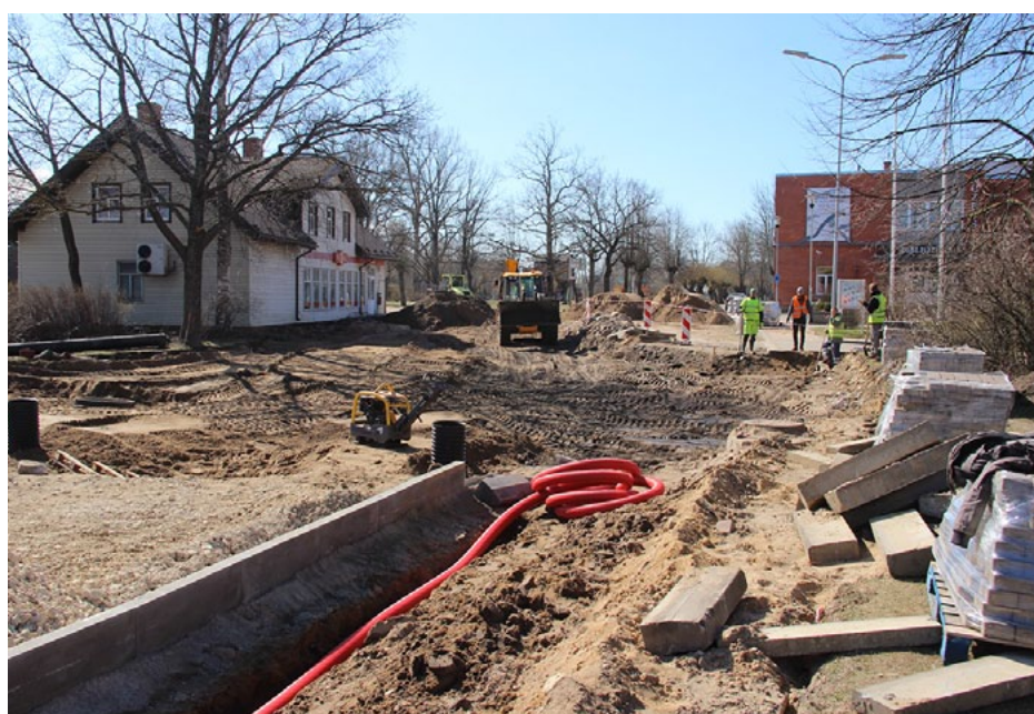
Remontdarbi Rīgas ielā ir pamatīgi
