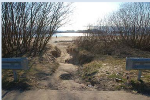
Kāpu erozija pie Muižuļu stāvvietas. (Foto: Baiba Strazdiņa)
