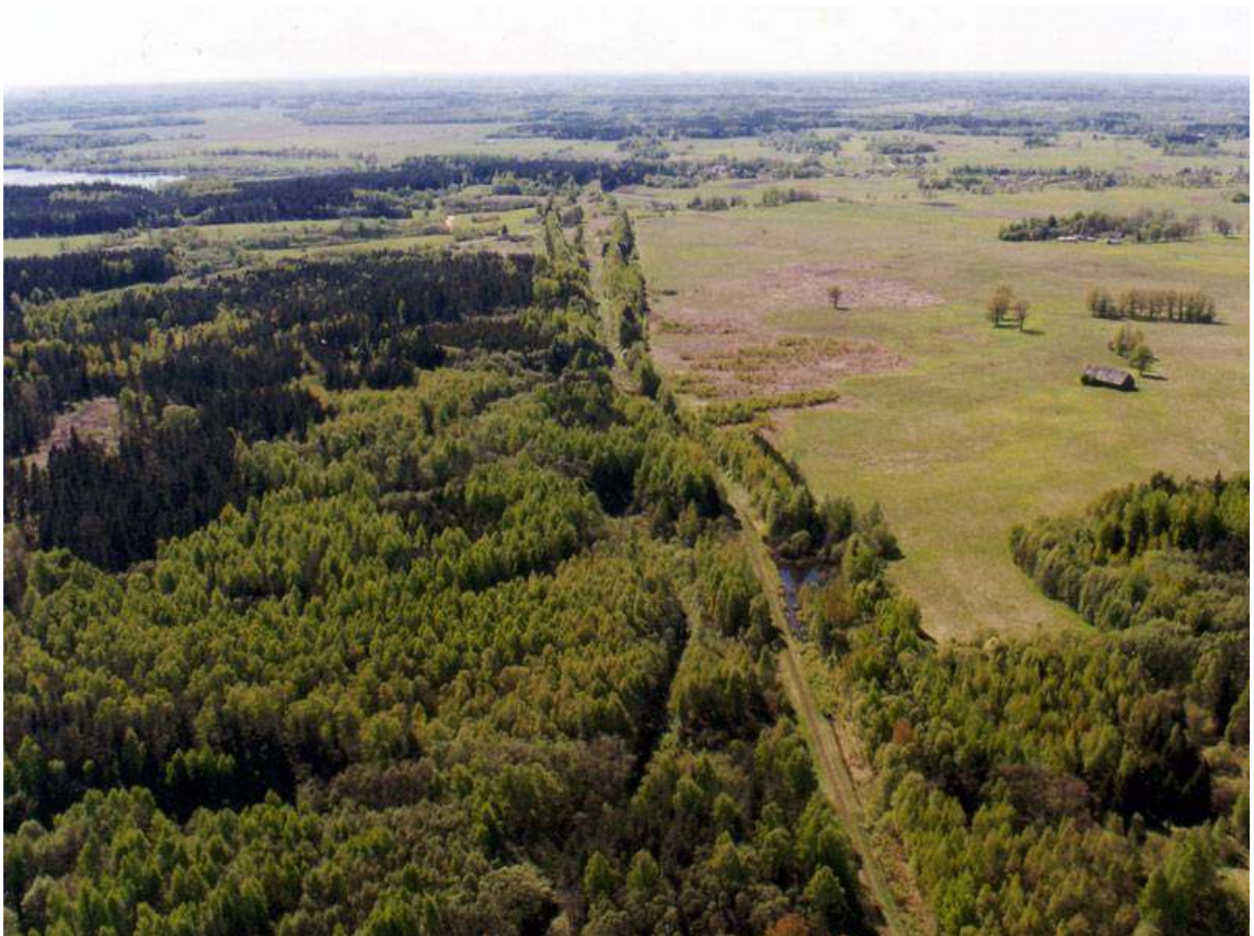
Attēls 29. Bānīša līnija starp Stāmerienu un Kalnienu
